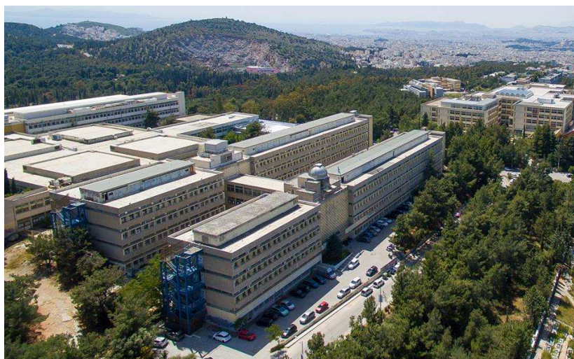
Εικ. 1: Γενική άποψη των κτηρίων όπου στεγάζεται το Τμήμα Φυσικής του ΕΚΠΑ. Φωτογραφία Σταμάτη Καλαμιώτη, Κοσμά Γαζέα.
